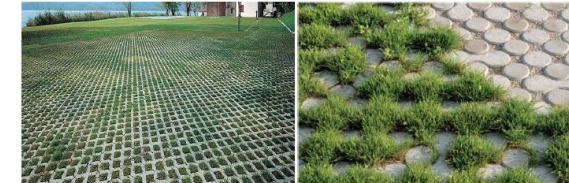
Figura 45: Esempio di pavimentazione drenante in beton (Fonte: https://www.dipintosucci.com/blog/progettare-un-parcheggio-paesaggistico/ ).
