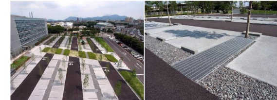
Figura 46: Gioco di pavimentazioni drenanti: tutta la pavimentazione del parcheggio è drenante (NSE Kitakyushu Technology Center, Giappone, Fukuoka, 2011) (Fonte: https://www.dipintosucci.com/blog/progettare-un-parcheggio-paesaggistico/ )
