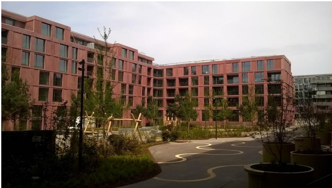
Neuüberbauung Roy, Winterthur
